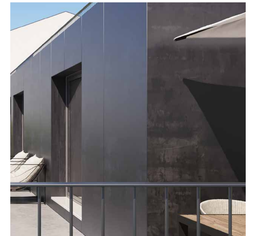
REVESTIMENTO Painéis em chapa de zinco cinza escuro CLADDING Dark grey zinc panels
